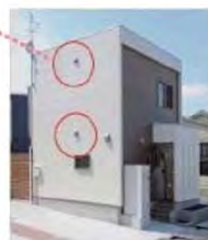
空気の通り道(換気口)をつけて湿気を排出します
