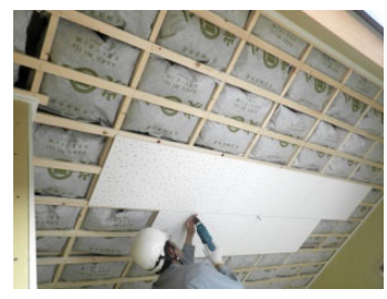
③天井に敷き詰め、有孔ボードを張り室内の湿気を吸収します
